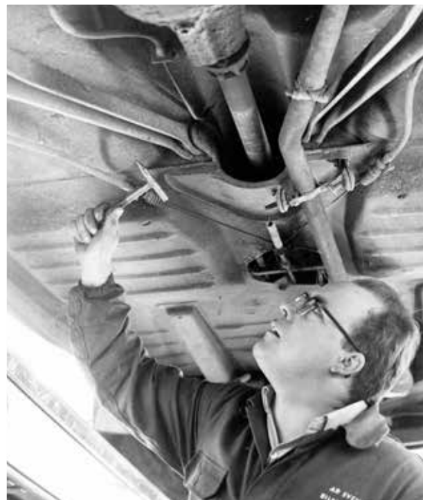
Den till synes primitiva rosthammaren är ett centralt redskap när ytterhöljets kondition ska bedömas. Årsta våren 1965: bromsprovare Bosch. AB Svensk Bilprovnings historiska arkiv hos Centrum för Näringslivshistoria.
